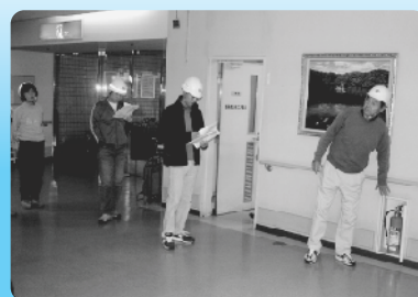
院内消火設備の点検
