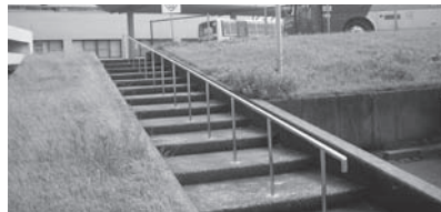
南西駐車場階段へ手すりを設置しました
