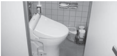
西館1階トイレを洋式化しました
