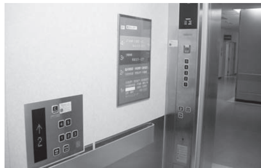
▲エレベーター設備を改修しました
