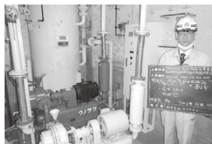
医療ガス設備更新工事
