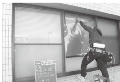
ガラス飛散防止フィルム設置工事
