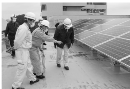
災害対応型太陽光発電設備
