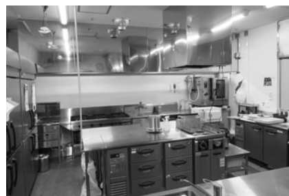
病院2階厨房改修
